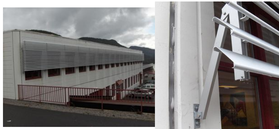
Skole i Flekkefjord: vertikal fast solskjerm i natureloksert aluminium Med C – profil lameller
